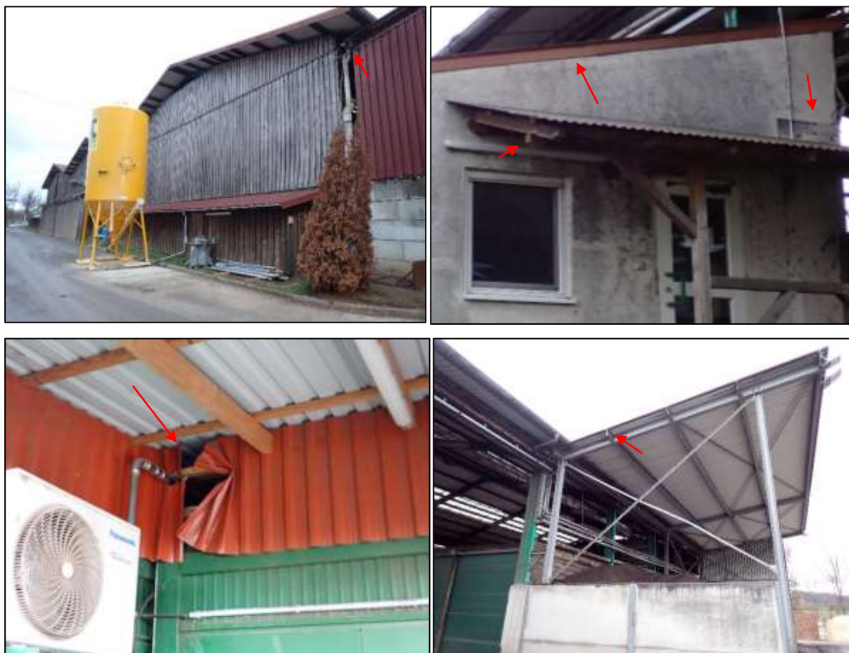
Abbildung 3: Außenverkleidung der Lagerhalle mit Spalten und Querbalken auf der Westseite (Foto links oben), angrenzendes Gebäude mit Attika und Löchern in der Außenfassade (Foto rechts oben), Einflugmöglichkeiten in das Container-Gebäude östlich der Lagerhalle (Foto links unten) sowie überdachte Querbalken an der Lagerhalle auf der Südseite (Foto rechts unten).
